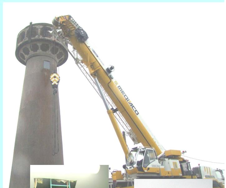
La mise en conformité de l'accès à l'intérieur du château d'eau a nécessité de gros moyens de levage, l'échelle intérieure qui devait être changée pour d'impérieuses raisons liées à sa vétusté ne pouvant être extraite que par la trappe supérieure de l'édifice. Il en était de même pour réimplanter à sa place une échelle en aluminium équipée d'une ligne de vie.
